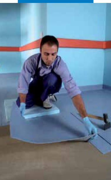
Montaż arkuszy wykładziny winylowej
